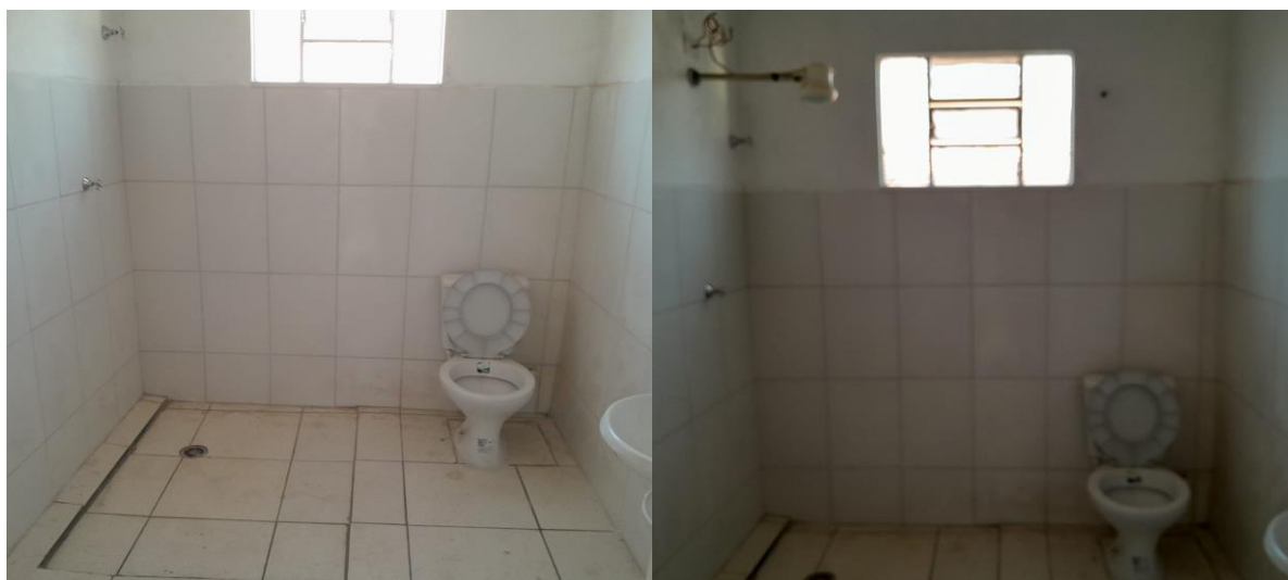
Adequação de banheiros
