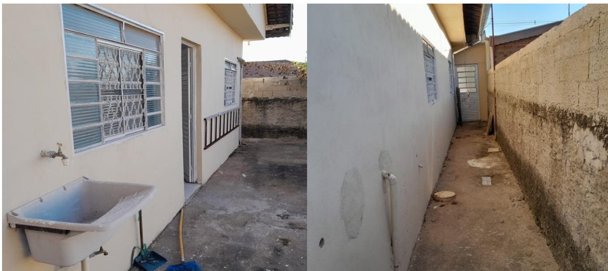
Adequação de áreas de lazer e acessos
